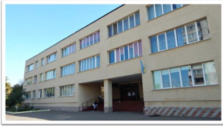
Будівля «Авторської школи М. П. Гузика», Одеська область, м. Южне, вул. Хіміків, 10-А
