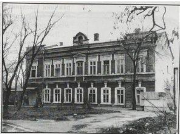
Второй причтовый дом Михайловской церкви постройки 1882 г. Фото 1996 г.
