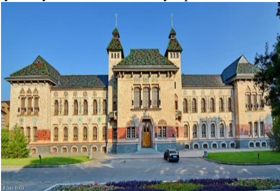
Рис. 1.2.1. Будівля Будинку Полтавського губернського земства
